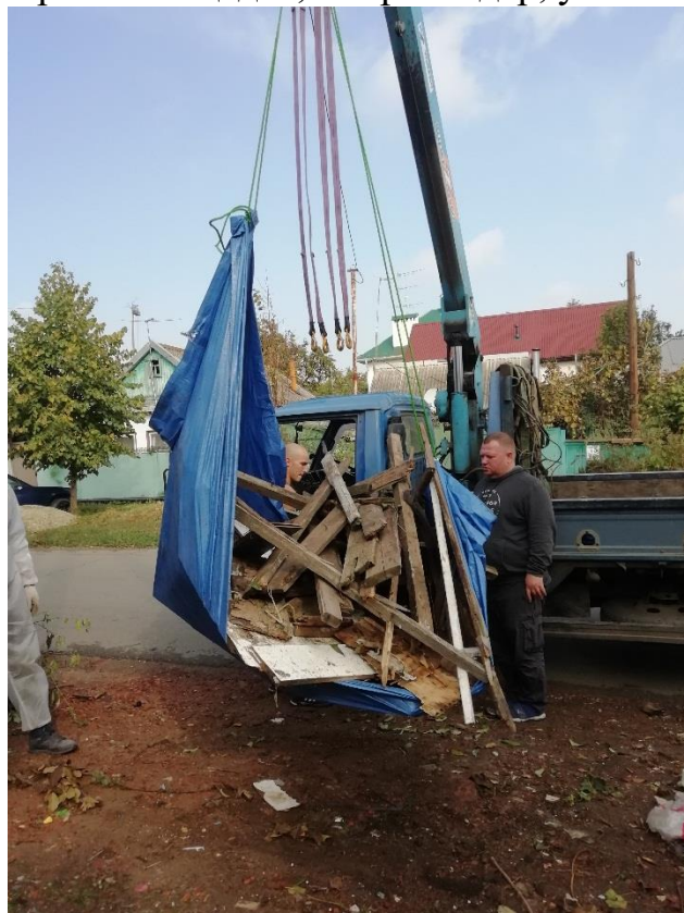
Рис.12. Взвешивание фракции: Доски, фанера, двери, линолеум, паркет, стекло, керамика, сантехника и прочее /контейнерная площадка, г. Краснодар, ул.Власова,68/
