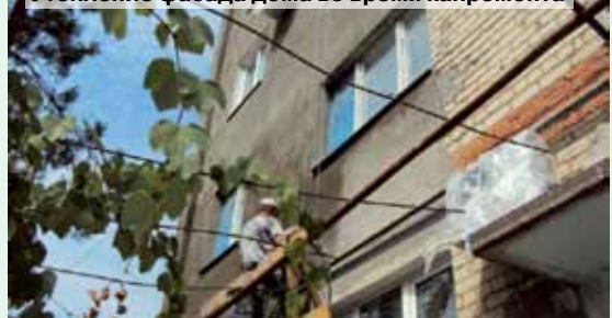
Утепление фасада дома во время капремонта
