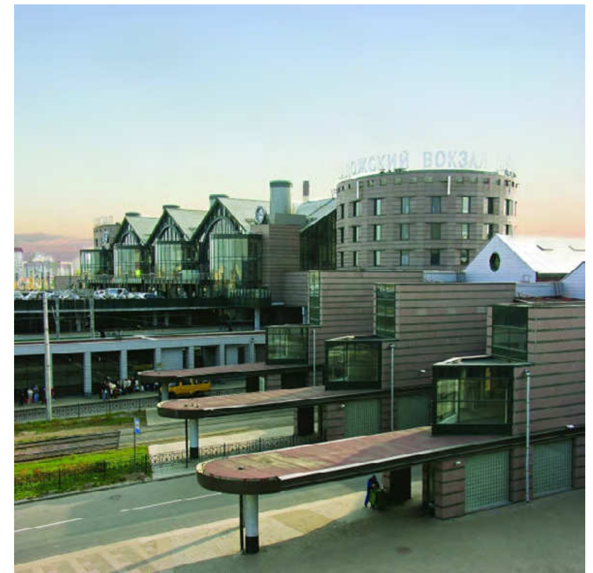
Вокзальный комплекс Ладожский, Санкт-Петербург Студия 44 Санкт-Петербург, Россия 2001 – 2002 / 2001 – 2003
