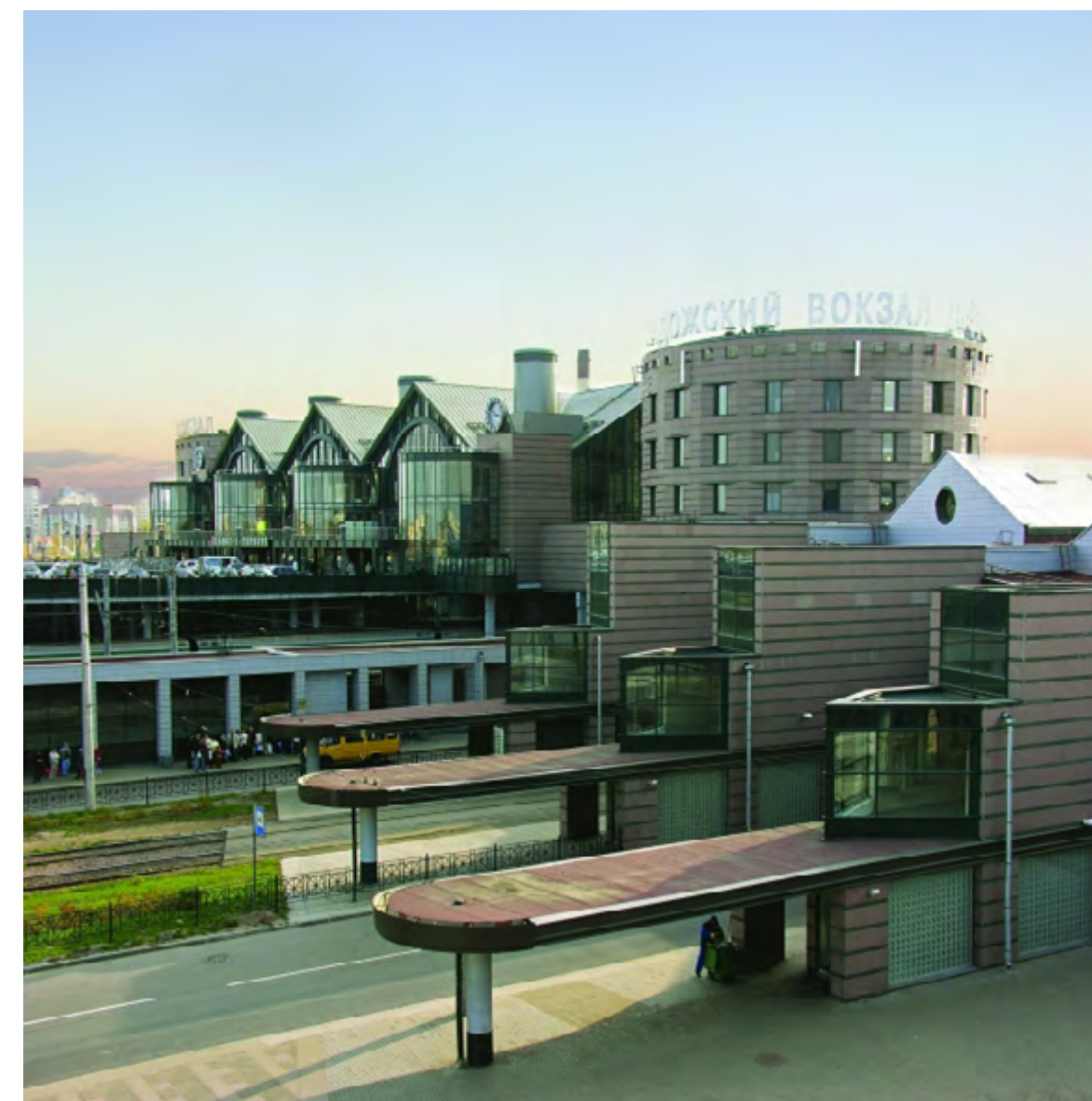
Вокзальный комплекс Ладожский, Санкт-Петербург Студия 44 Санкт-Петербург, Россия 2001 – 2002 / 2001 – 2003
